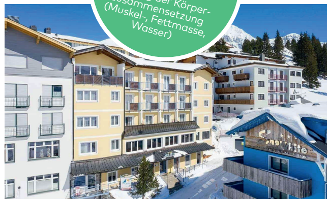
Hotel Solaria Ringstraße 6 5562 Obertauern hotel-solaria.at
