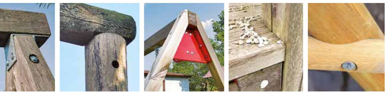
○ Durch saubere Konstruktionsverbindungen bzw. durch Einbau von Abstandhaltern werden gefährliche Fangstellen für Bänder, Haare, Finger usw. verhindert!
