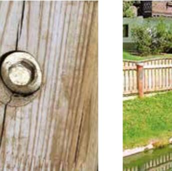
Versetzen Sie überstehende Schrauben und Befestigungseisen.
