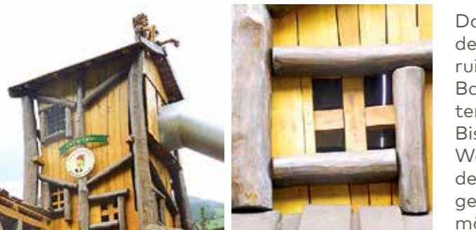
Das „Baumhaus“ ist ein Pfahlhaus, dass in den Baum oder um den Baum herum konstruiert wird. Ein Beklettern des Baumes vom Baumhaus aus darf nicht möglich sein. Fensteröffnungen müssen kleiner als 89 mm sein. Bis 3 m Höhe ist ein Fallschutz erforderlich. Werden Baumhäuser höher gebaut, so muss der Zugang ab 3 m Höhe geschlossen erfolgen. Ein „Balkon“ ist in diesen Fällen nicht möglich.
