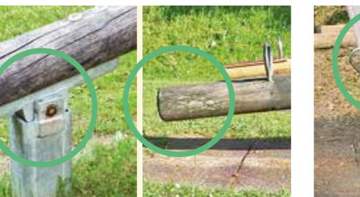
Konstruktiv werden Klemm- und Quetschstellen für Finger, Fuß und Kopf vermieden. Bodenfreiheit mehr als 23 cm.
