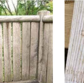
Bringen Sie ab einer Fallhöhe von 60 cm Brüstungen an. Abstand zwischen den Latten max. 89 mm.
