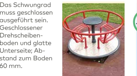
Das Schwungrad muss geschlossen ausgeführt sein. Geschlossener Drehscheibenboden und glatte Unterseite; Abstand zum Boden 60 mm.
