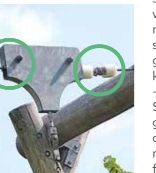
Der Anschlag an der Endstation muss gebremst werden. Die Laufkatze muss gegen das Herauspringen und Eingreifen gesichert werden (Verkleidung). Der Seilfreiraum – Oberkante Sitz bis zum Seil – muss 210 cm betragen. Das Seil darf wegen der Strangulierungsgefahr nicht zu einer Schlinge formbar sein.
