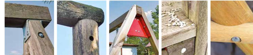
○ Durch saubere Konstruktionsverbindungen bzw. durch Einbau von Abstandhaltern werden gefährliche Fangstellen für Bänder, Haare, Finger usw. verhindert!
