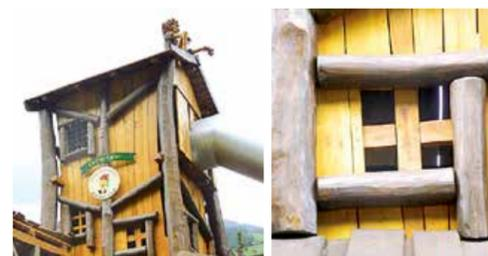
Das „Baumhaus“ ist ein Pfahlhaus, dass in den Baum oder um den Baum herum konstruiert wird. Ein Beklettern des Baumes vom Baumhaus aus darf nicht möglich sein. Fensteröffnungen müssen kleiner als 89 mm sein. Bis 3 m Höhe ist ein Fallschutz erforderlich. Werden Baumhäuser höher gebaut, so muss der Zugang ab 3 m Höhe geschlossen erfolgen. Ein „Balkon“ ist in diesen Fällen nicht möglich.
