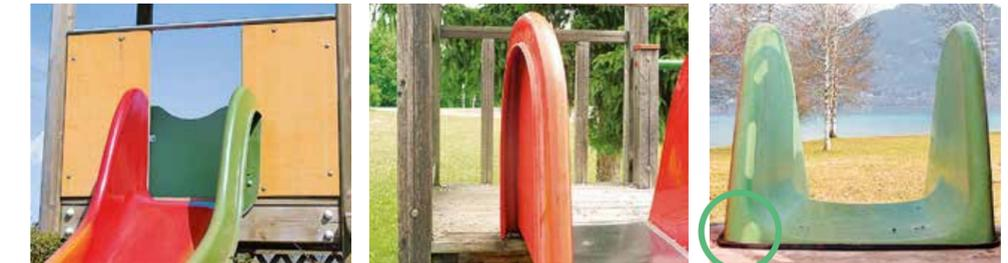
Fangstellen am Boden des Rutscheneinstieges und bei den seitlichen Wangen sind kaum möglich. Beim Einrichten der Plattform für die Montage muss hier aber sehr genau gearbeitet werden, ...
