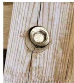
Versenken Sie überstehende Schrauben und Befestigungseisen.
