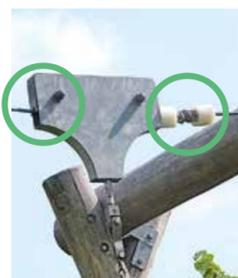
Der Anschlag an der Endstation muss gebremst werden. Die Laufkatze muss gegen das Herauspringen und Eingreifen gesichert werden (Verkleidung). Der Seilfreiraum – Oberkante Sitz bis zum Seil – muss 210 cm betragen. Das Seil darf wegen der Strangulierungsgefahr nicht zu einer Schlingenform sein.
