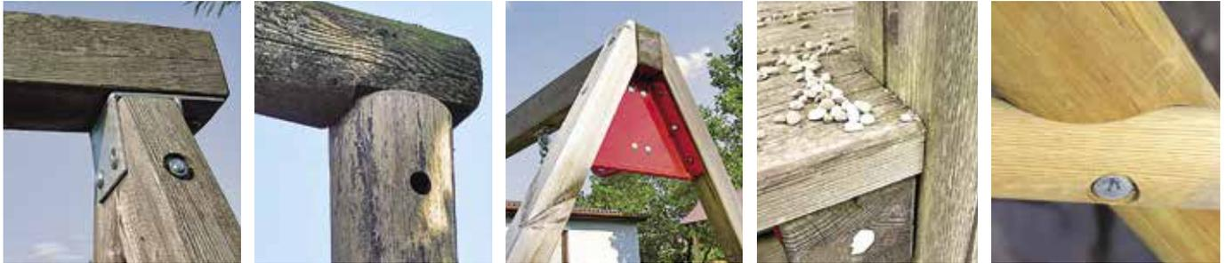
○ Durch saubere Konstruktionsverbindungen bzw. durch Einbau von Abstandhaltern werden gefährliche Fangstellen für Bänder, Haare, Finger usw. verhindert!
