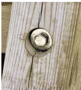
Versenken Sie überstehende Schrauben und Befestigungseisen.
