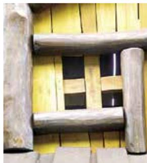
Das „Baumhaus“ ist ein Pfahlhaus, dass in den Baum oder um den Baum herum konstruiert wird. Ein Beklettern des Baumes vom Baumhaus aus darf nicht möglich sein. Fensteröffnungen müssen kleiner als 89 mm sein. Bis 3 m Höhe ist ein Fallschutz erforderlich. Werden Baumhäuser höher gebaut, so muss der Zugang ab 3 m Höhe geschlossen erfolgen. Ein „Balkon“ ist in diesen Fällen nicht möglich.
