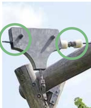
Der Anschlag an der Endstation muss gebremst werden. Die Laufkatze muss gegen das Herauspringen und Eingreifen gesichert werden (Verkleidung). Der Seilfreiraum – Oberkante Sitz bis zum Seil – muss 210 cm betragen. Das Seil darf wegen der Strangulierungsgefahr nicht zu einer Schlingenförmig sein.
