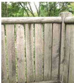
Bringen Sie ab einer Fallhöhe von 60 cm Brüstungen an. Abstand zwischen den Lat-tungen max. 88 mm.
