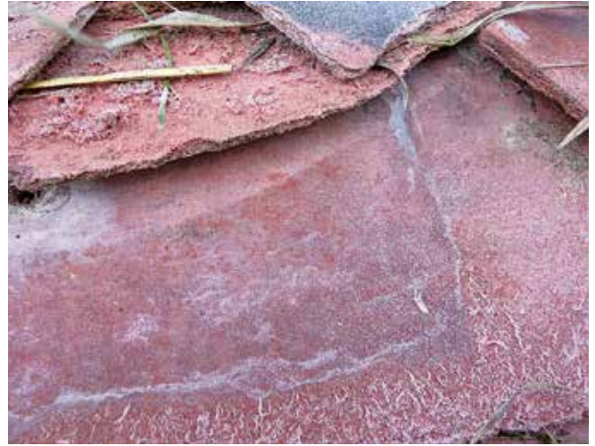
Asbesthaltige Dachplatten
