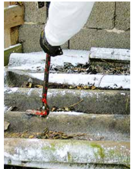
Demontage und Entsorgung von asbesthaltigen Welleternitdachplatten. Verwendung von Einwegoverall, Atemschutzmaske FFP2, Arbeitshandschuhe
