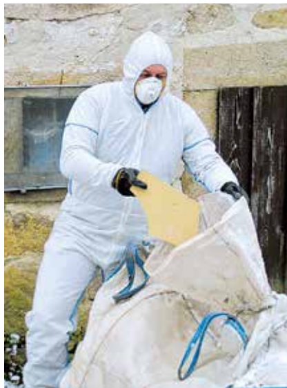
Demontage und Entsorgung von asbesthaltigen Welleternitdachplatten. Verwendung von Einwegoverall, Atemschutzmaske FFP2, Arbeitshandschuhe
