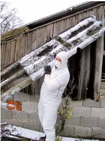
Demontage und Entsorgung von asbesthaltigen Welleternitdachplatten. Verwendung von Einwegoverall, Atemschutzmaske FFP2, Arbeitshandschuhe
