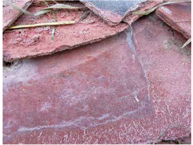
Asbesthaltige Dachplatten
