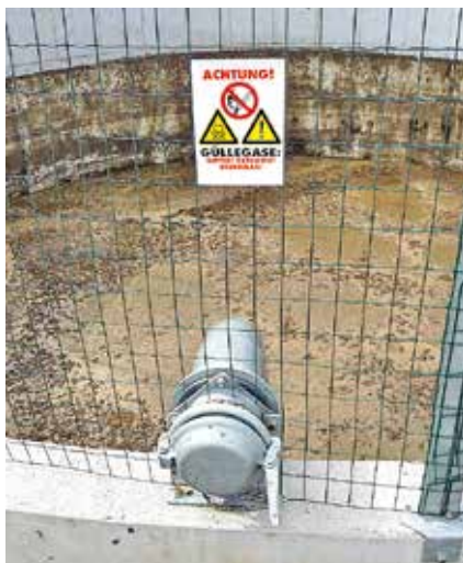
Grube mit fest montiertem Ansaugrohr und Warntafel
