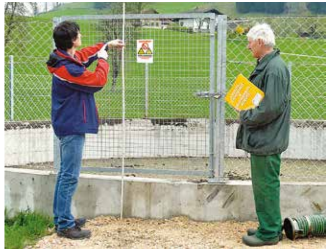
Offene Güllegrube mit 1,8 m hoher Umzäunung, Anfahrerschutz, Vorhängeschloss und Warntafel
