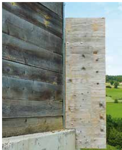
Schutz gegen Zugang zu ungesicherter Mauerkrone
