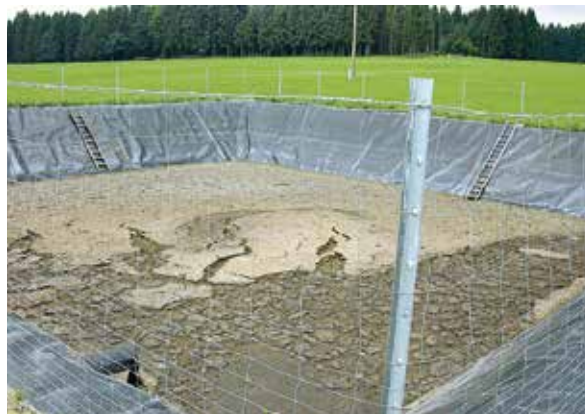
Güllelagune mit Rettungsleitern
