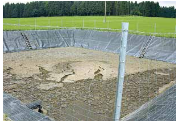
Güllelagune mit Rettungsleitern
