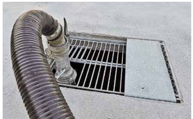
Mehrteiliger Deckel mit Saugrohr- bzw. Rühröffnung und Entlüftungsschlitzen
