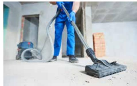
Geeignete Industriestaubsauger helfen, die Staubbelastung auf Baustellen zu senken.
