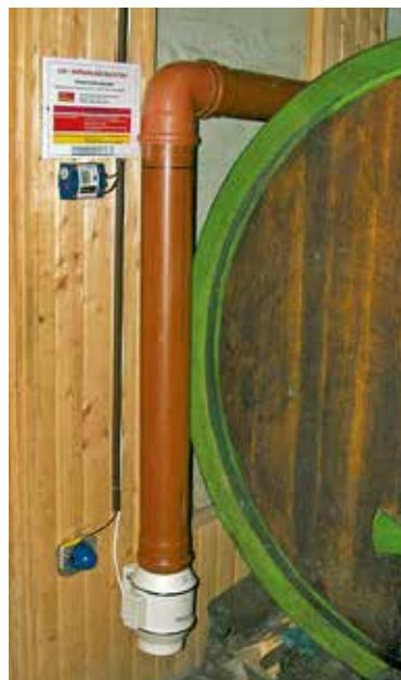
Die Installation eines Kohlenstoffdioxid-Warngerätes, das mit einem Exhaustor gekoppelt ist, stellt die beste Möglichkeit dar, lebensbedrohliche Gärgaskonzentrationen erst gar nicht entstehen zu lassen.
