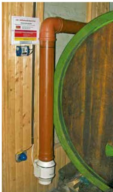
Die Installation eines Kohlenstoffdioxid-Warngerätes, das mit einem Exhauster gekoppelt ist, stellt die beste Möglichkeit dar, lebensbedrohliche Gärgaskonzentrationen erst gar nicht entstehen zu lassen.
