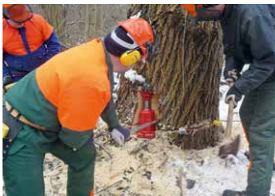
Die Baumfällung wird hydraulisch unterstützt.
