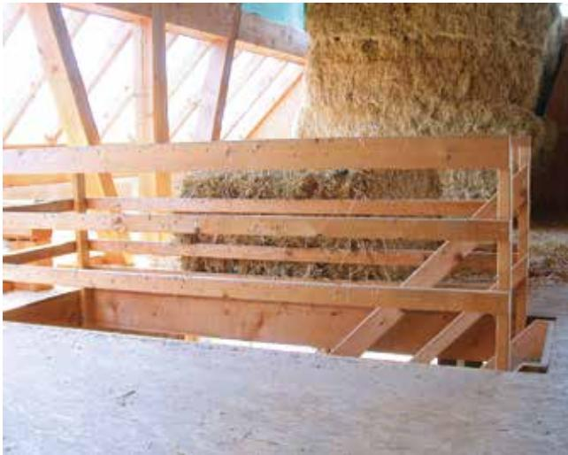
Der **Stiegenaustritt** ist mit einer Umwehrung gegen Absturz von Personen zu sichern. **Stiegen** müssen mit einem Handlauf ausgestattet und auf der freien Seite mit einem Geländer gesichert sein.
