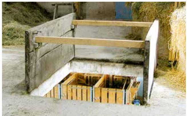
Große Luken im befahrbaren Bereich, die mit einem **zweiflügeligen Deckel** verschlossen werden, können durch die Verbindung der beiden Deckelhälfte mit einschiebbaren Querhölzern gesichert werden.
