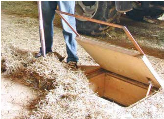
Im Verkehrsbereich bieten sich mittels Zahnrasterstange schräg fixierte, durch einen flachen Metallrahmen verlängerte Lukendeckel an. Diese müssen einen mindestens 20 cm großen Überstand über die Lukenöffnungen aufweisen und dürfen nicht weiter als 45° geöffnet werden können.
