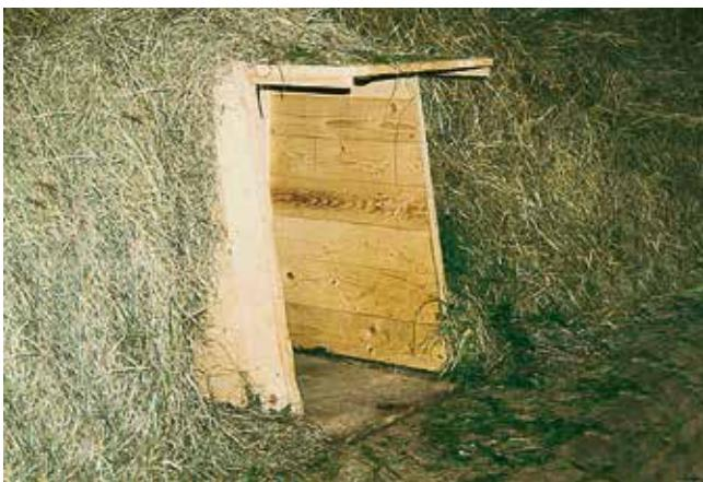
**Überdeckte Lukenöffnungen** sind arbeitstechnisch vorteilhafter und wesentlich sicherer. Eine überbaute Luke ermöglicht eine problemlose Lagerung über dem Lukenbereich, da die Bodenfläche nicht verkleinert wird.
