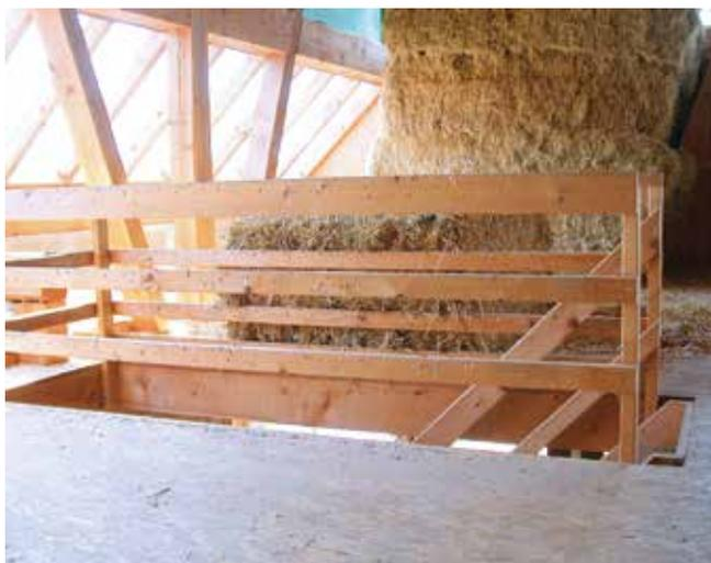
Der **Stiegenaustritt** ist mit einer Umwehung gegen Absturz von Personen zu sichern. **Stiegen** müssen mit einem Handlauf ausgestattet und auf der freien Seite mit einem Geländer gesichert sein.
