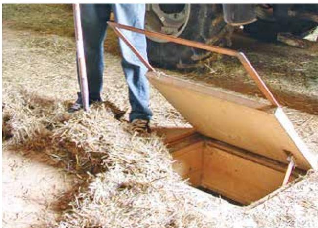
Im Verkehrsbereich bieten sich mittels Zahnraststange **schräg fixierte, durch einen flachen Metallrahmen verlängerte Lukendeckel** an. Diese müssen einen mindestens 20 cm großen Überstand über die Lukenöffnungen aufweisen und dürfen nicht weiter als 45° geöffnet werden können.
