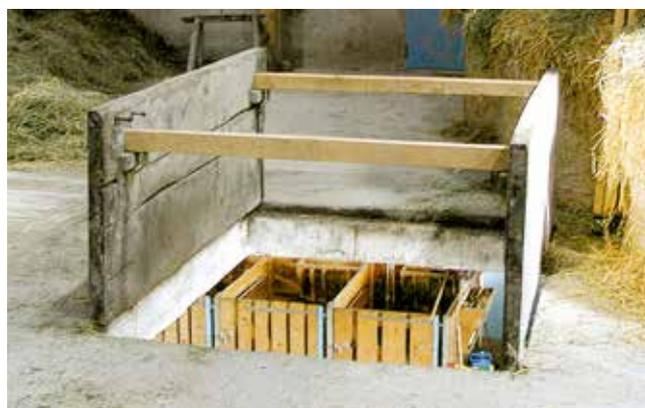
Große Luken im befahrbaren Bereich, die mit einem **zweiflügeligen Deckel** verschlossen werden, können durch die Verbindung der beiden Deckelhälften mit einschiebbaren Querhölzern gesichert werden.
