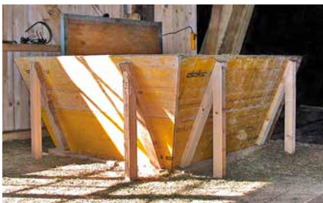
Ist ein Heukran vorhanden, empfiehlt sich die Sicherung der Luke mit einem **Abwurftrichter**. Anstatt dem schwenkbaren Deckel kann ein Schiebedeckel an der Stalldecke angebracht werden.
